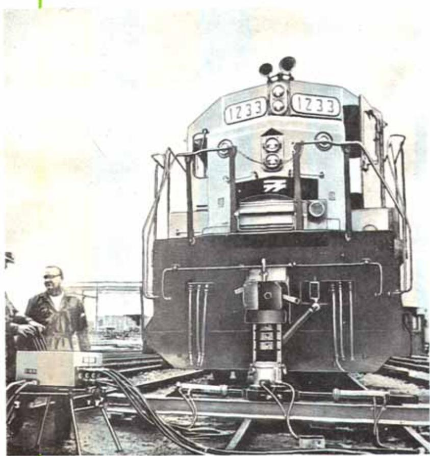
Detalhe da execução da operação, pela superposição dos calços ferradura e dos calços bolacha após sucessivas elevações e retrações do pistão.
